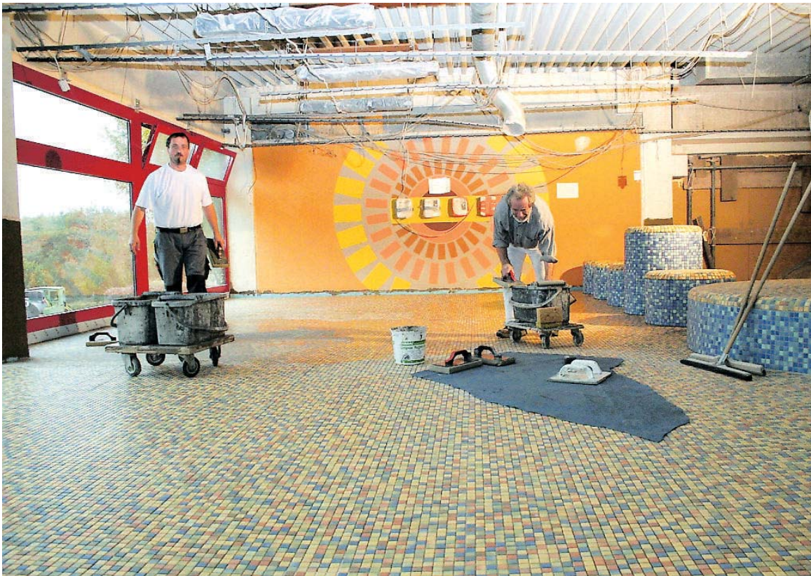
Während der Umbauarbeiten: Neue farbenfrohe Fliesen für den Ruhebereich des Püttlinger Trimmtreff-Bades. Fotos: SZ/Stadt Püttlingen
