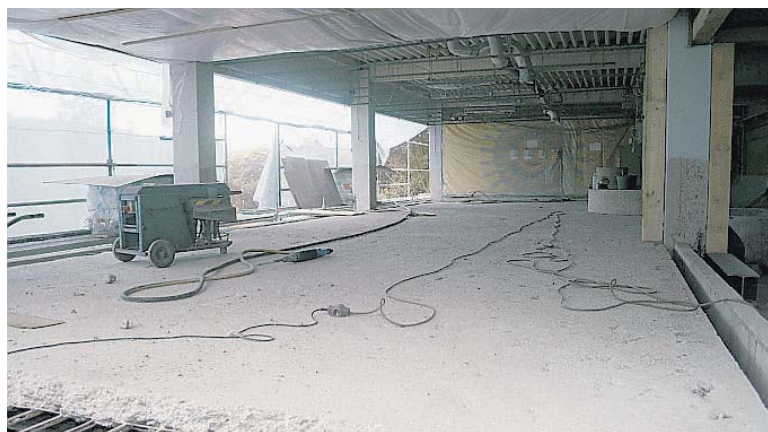
Neue wärmegeklämmt Aluminiumkonstruktion (links).
